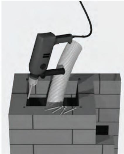
Schachtmündung vorbereiten für die Montage des Mündungsübergangs zur metallischen Schachtabdeckung. Hierzu die vier Befestigungspunkte festlegen und Bohrungen für mitgelieferte Schlagdübel M6 vornehmen.
