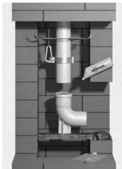
Senkrechte Abgasleitung mit Stützbogen verbinden. Eventuelle Verunreinigungen an der Muffe des Stützbogens entfernen. Skoberne Gleitmittel verwenden.
