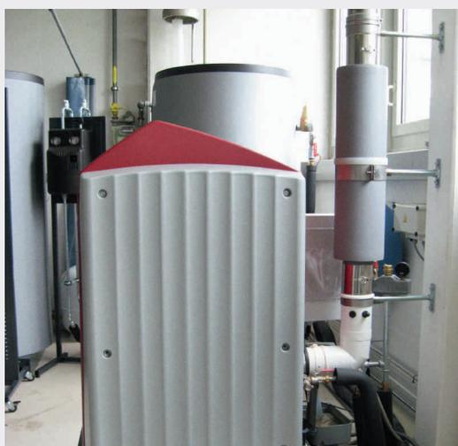
Fig. 6 Aufbau mit LAS-Schalldämpfer
