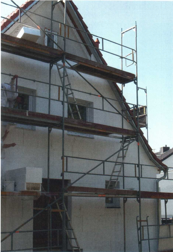
Schon vor der Fertigstellung des WDVS verschwindet der Schacht unsichtbar in der Wärmedämmung.
