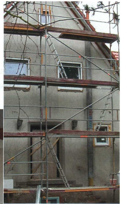
Keine Deckendurchbrüche, klare Befestigungstechnik und ein unweigerlich ohnehin vorhandenes Gerüst machen den Aufbau leicht. Innerhalb von 1,5 Stunden ist der Schacht montiert.
