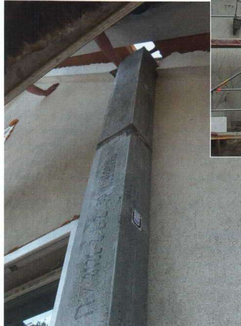
Keine Deckendurchbrüche, klare Befestigungstechnik und ein unweigerlich ohnehin vorhandenes Gerüst machen den Aufbau leicht. Innerhalb von 1,5 Stunden ist der Schacht montiert.
